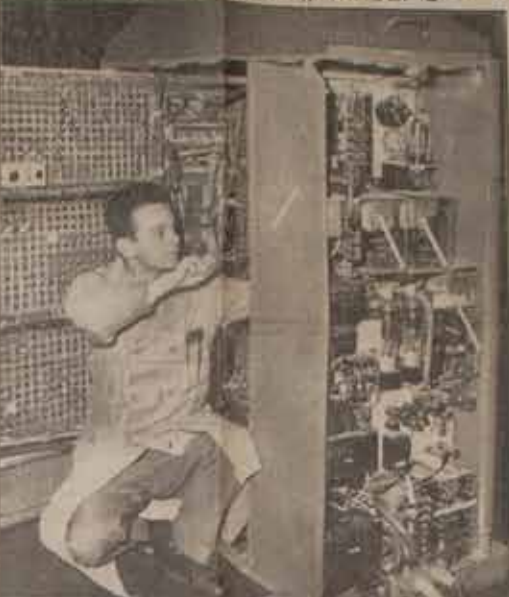
De man aan de afgebeelde afrekenmachine berekent de belastingaanslagen op basis van de gegevens die op de ponskaarten zijn vermeld.
